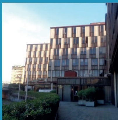
Greenstone Sicaf SpA Ristrutturazione di complesso terziario a Roma
